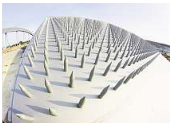
Scharfe Spitzen sollen abschrecken, die Bögen zu erklimmen. Sie sind bis zur Höhe von 28 Metern über der Elbe angebracht. Foto: SZ/Peter Hilbert
